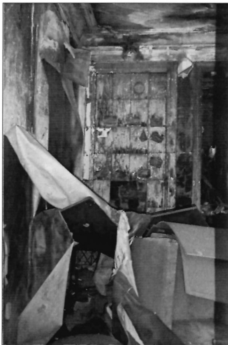
13. Фрагмент помещения Объекта. Декор потолка. Фото 2022 г.
