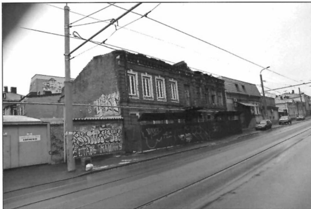
1. Общий вид Объекта с юго-запада. Фото 2023 г.
