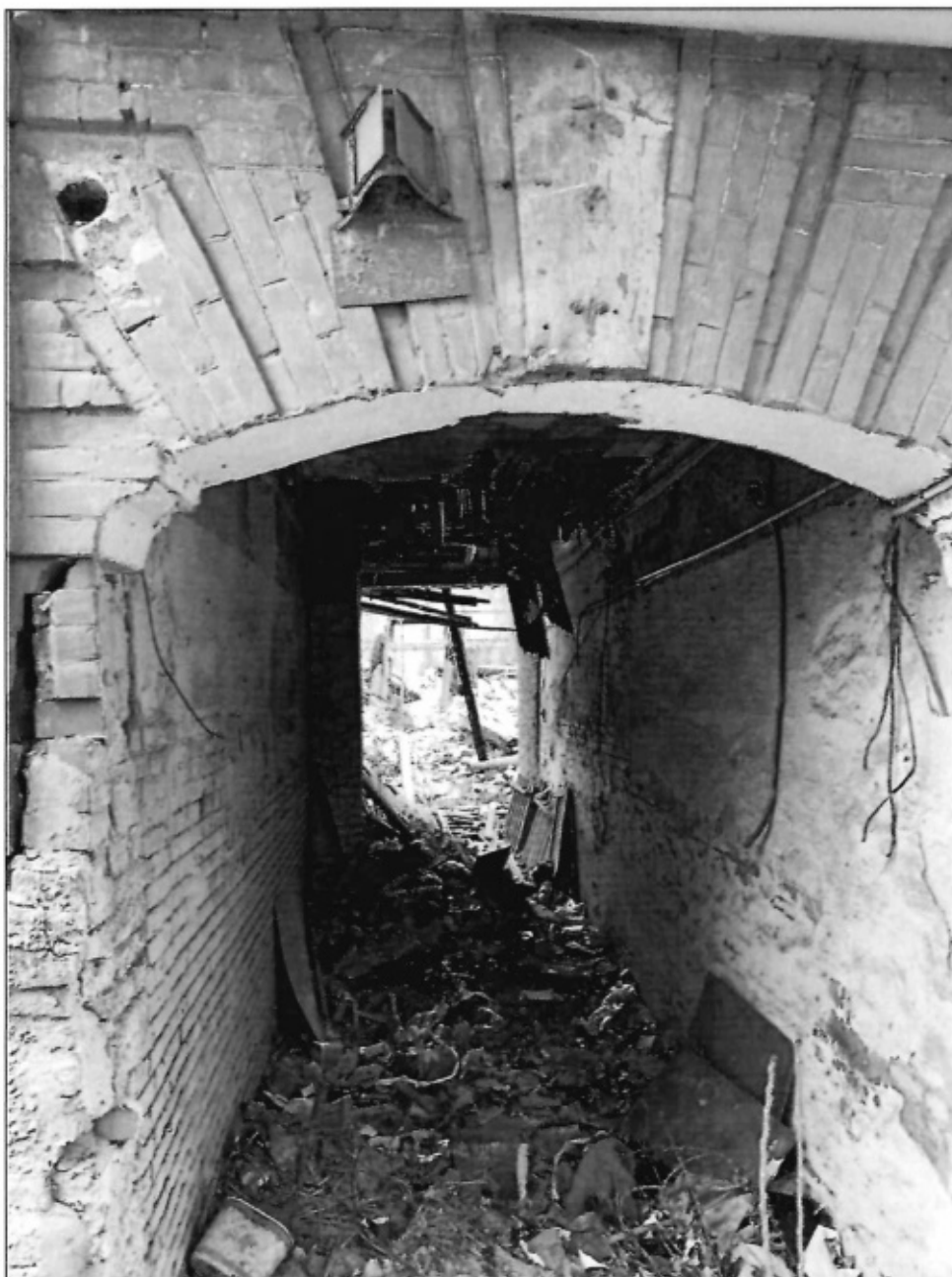
10. Фрагмент главного южного фасада Объекта. Проем внутридворового проезда. Фото 2023 г.
