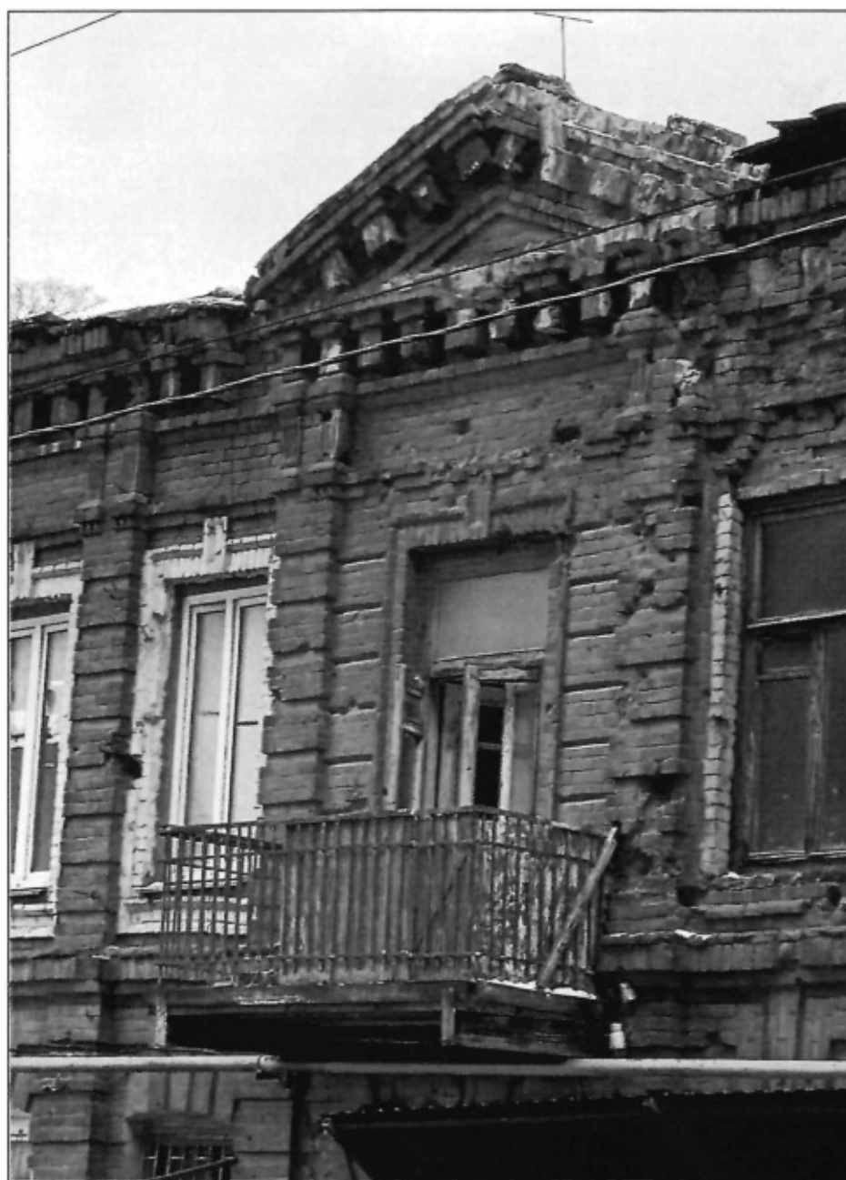
9. Фрагмент центральной раскреповки в уровне второго этажа главного южного фасада Объекта. Фото 2023 г.
